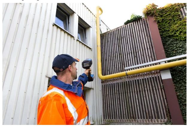
Darüber hinaus besitzt der **RMLD-CS** ein Kamerabild in dem der untersuchte Bereich eingeblendet wird. Die enthaltene SD-Karte speichert, zusätzlich zum Kamerabild, auch die zugehörigen Messwerte. Dies ermöglicht eine besonders effiziente Dokumentation der gefundenen Leckagestellen.
